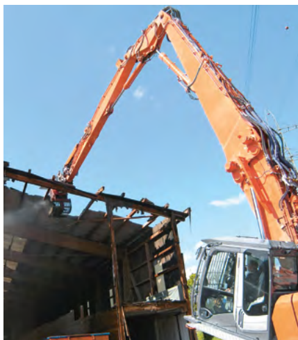
4 Lastre ondulate contenenti amianto
