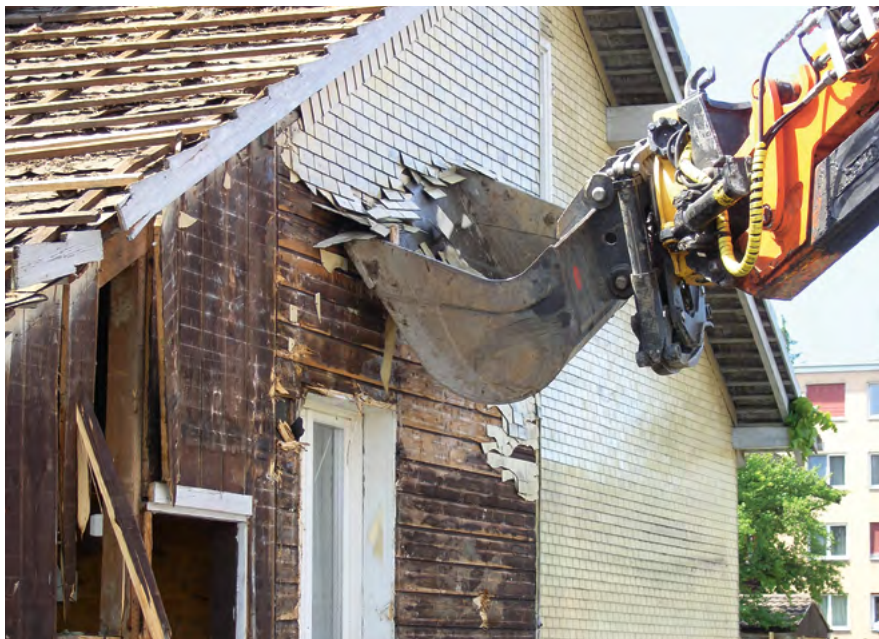
3 Scandole in fibrocemento contenente amianto
