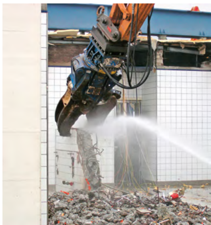
7 Piastrelle ceramiche contenenti colla a base di amianto
