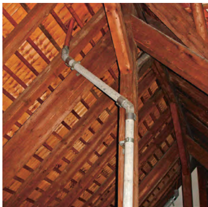
6 Tubazioni in fibrocemento contenente amianto
