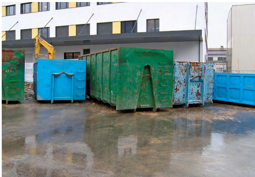
2 Container per amianto
